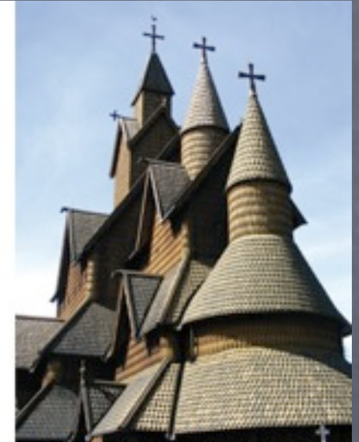
GOL STAVKIRKE. Et varmere og våtere klima vil øke belastningen på verdifulle trebygninger. Foto: Caroline Forster
